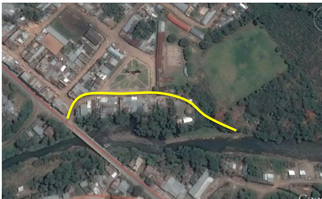
Fotografía N°11 , Margen izquierda del Río Naranjillo, zona en peligro muy alto ante un movimiento sísmico o a deslizamiento por la acción de la erosión fluvial del río Naranjillo.
