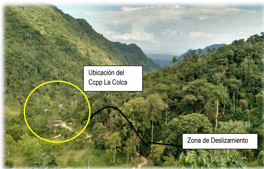
Foto N° 10: Identificación del Ccpp La Colca, ubicado en montañas estructurales de fuerte pendiente, y reactivación de deslizamientos producto de la deforestación.
