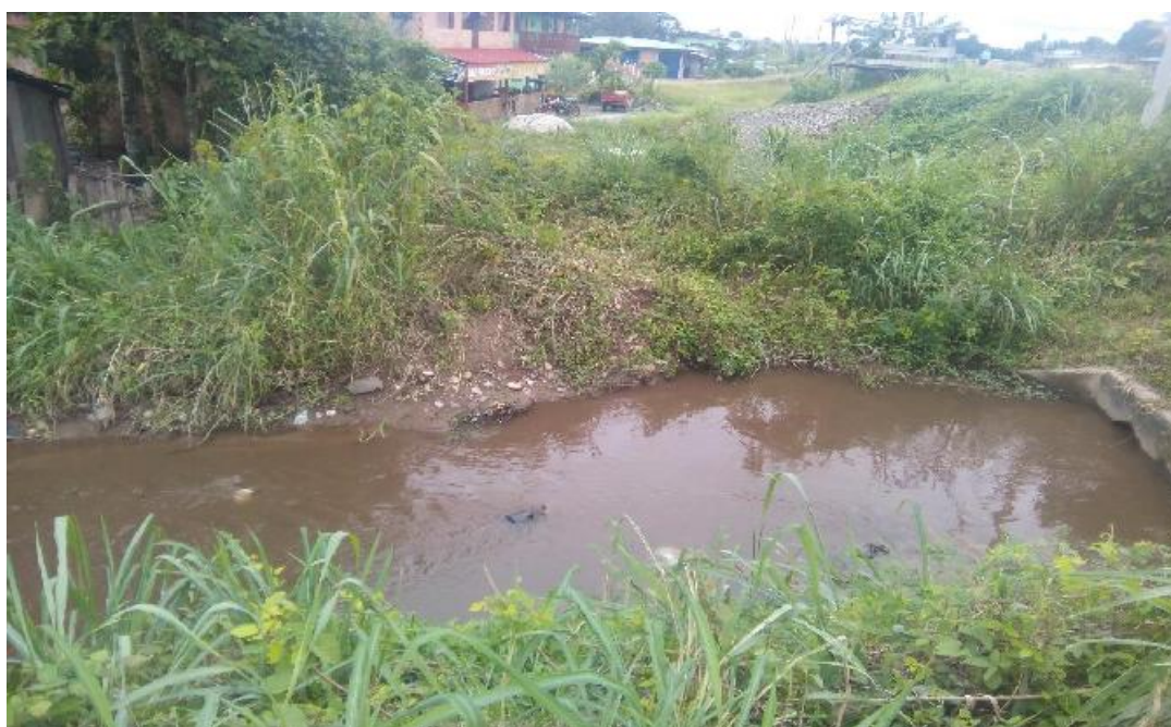
Fotografía N°12 , se muestra en la capacidad máxima de evacuación de aguas pluviales en el sector San Luis, margen derecha del río Naranjillo.
